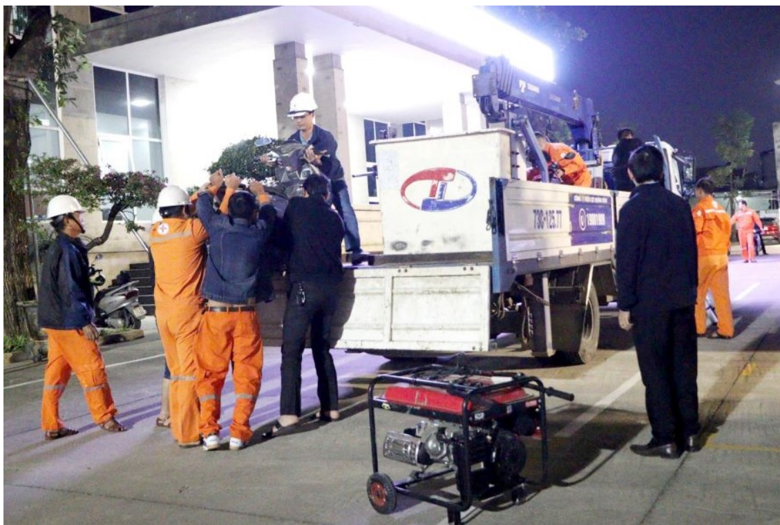
Cán bộ, công nhân PC Quảng Trị chuẩn bị vật tư, trang thiết bị chuyên dụng trước lúc lên đường hỗ trợ khôi phục lưới điện sau mưa lũ tại Đắk Lắk. (Ảnh: MN)
