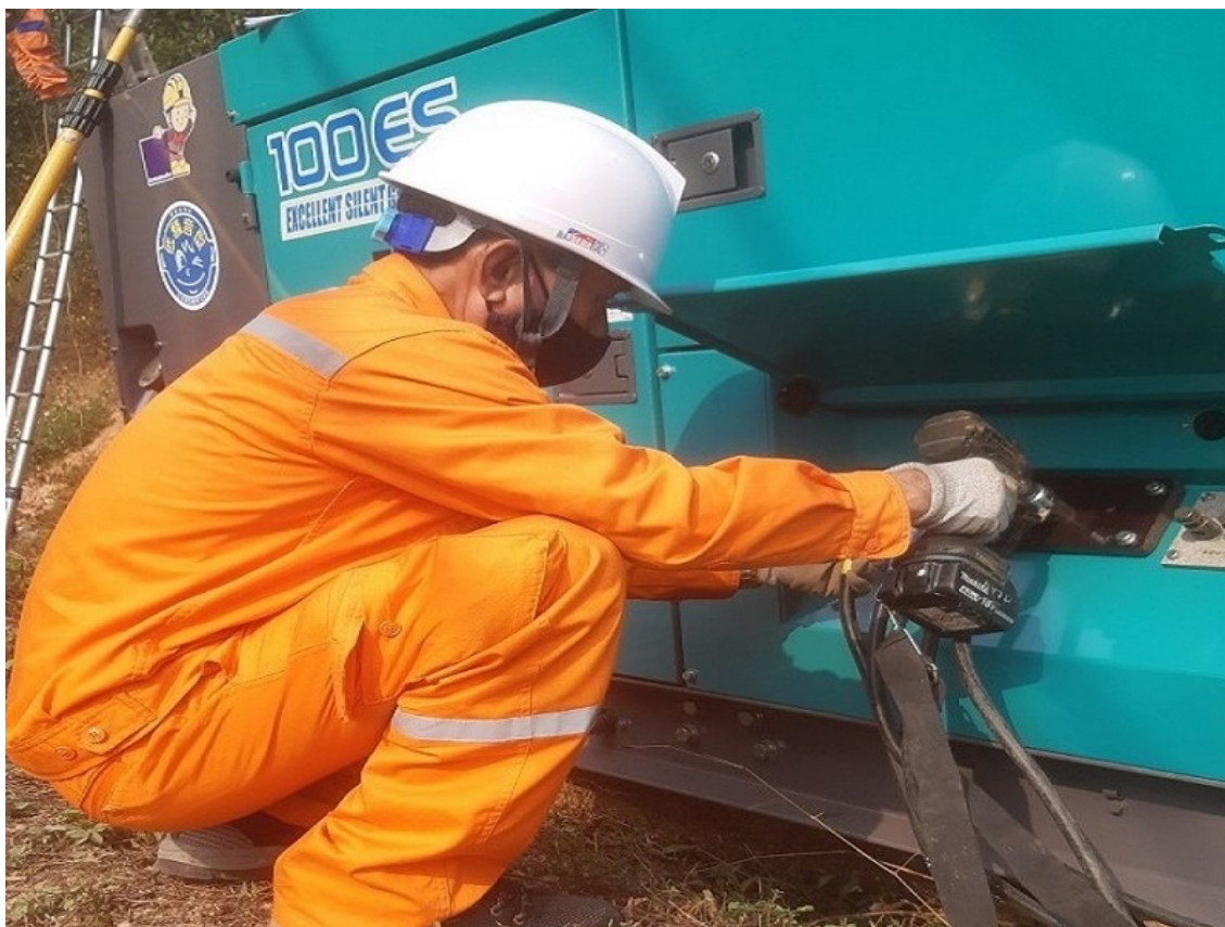
Công nhân thực hiện lắp máy phát điện dự phòng.
