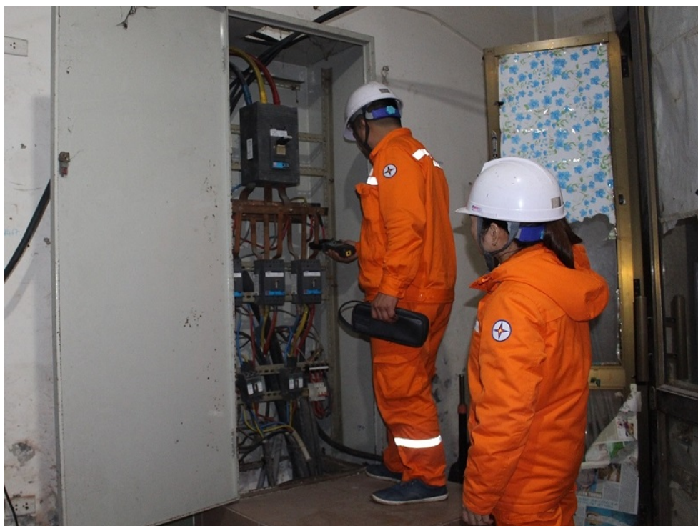
Công nhân thực hiện kiểm tra nguồn cấp cho nhà thi đấu.
