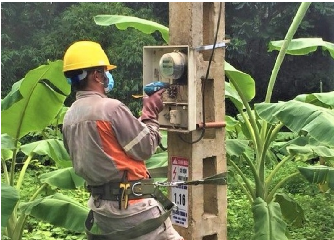
Công nhân tháo bỏ công tơ cơ khí cũ để chuẩn bị thay thế lắp đặt công tơ điện tử.
