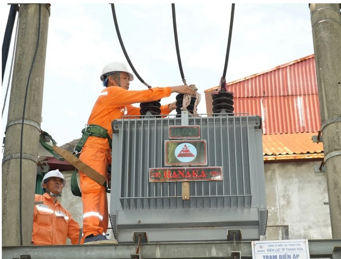
Công nhân PC Thanh Hóa vệ sinh máy biến áp
