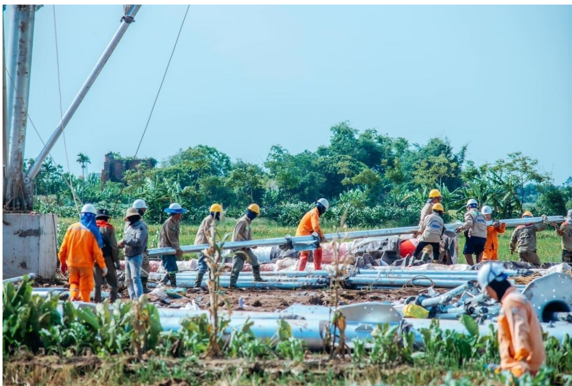
Người lao động PETROCONS luôn nỗ lực "vượt nắng, thắng mưa" trên những công trình, dự án
