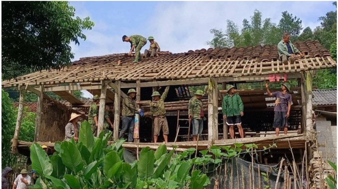
Thi đua “Chung tay xóa nhà tạm, nhà dột nát trên phạm vi cả nước trong năm 2025”. Ảnh chinhphu.vn.
