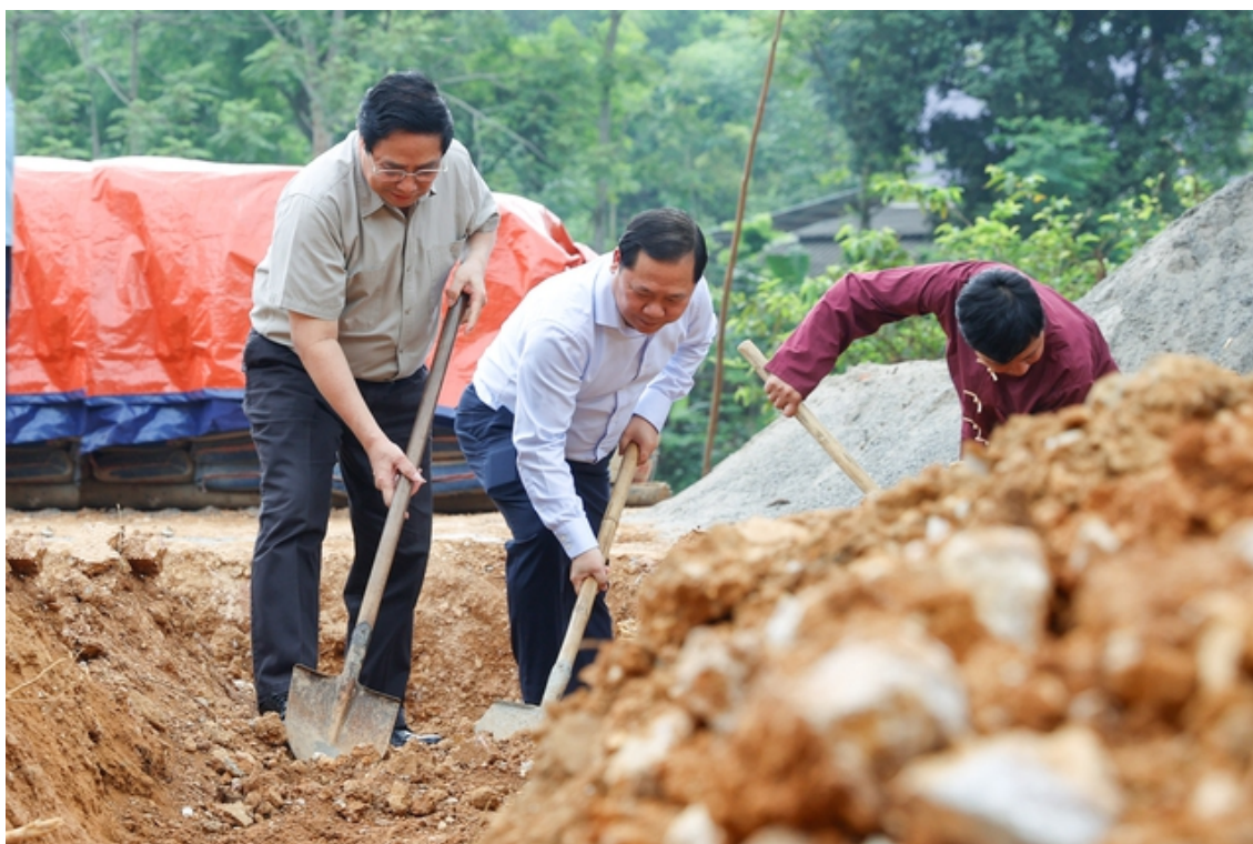
Thủ tướng tham gia khởi công xây nhà mới cho hộ gia đình ông Xa Văn Vọng, xóm Sơn Phú, xã Cao Sơn, huyện Đà Bắc, tỉnh Hòa Bình. Ảnh VGP/Nhật Bắc.
