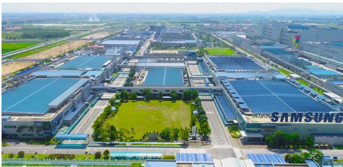
Khu công nghiệp Yên Phong.
