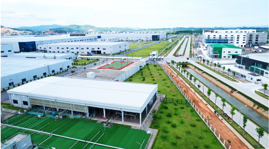
Khu công nghiệp Sông Khoai, Quảng Yên, Quảng Ninh (Ảnh: QMG)
