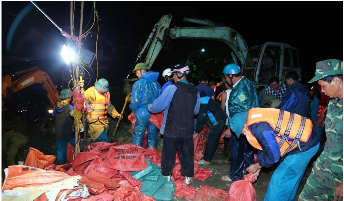
Các lực lượng tập kết đất, cát, bao tải xử lý khẩn cấp sự cố.
