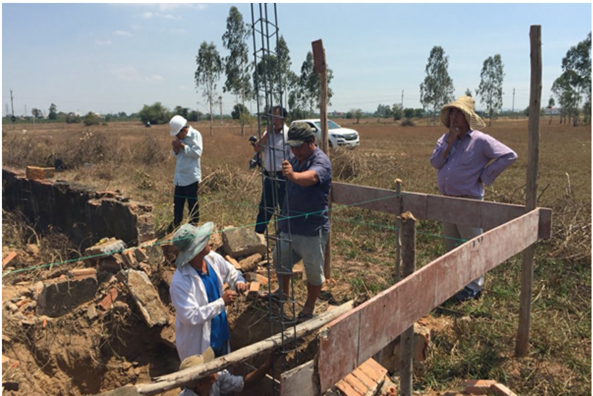
Tập đoàn Việt Úc đang xây dựng nhà máy sản xuất nước khoáng đóng chai Aloha tại xã Mường Mán
