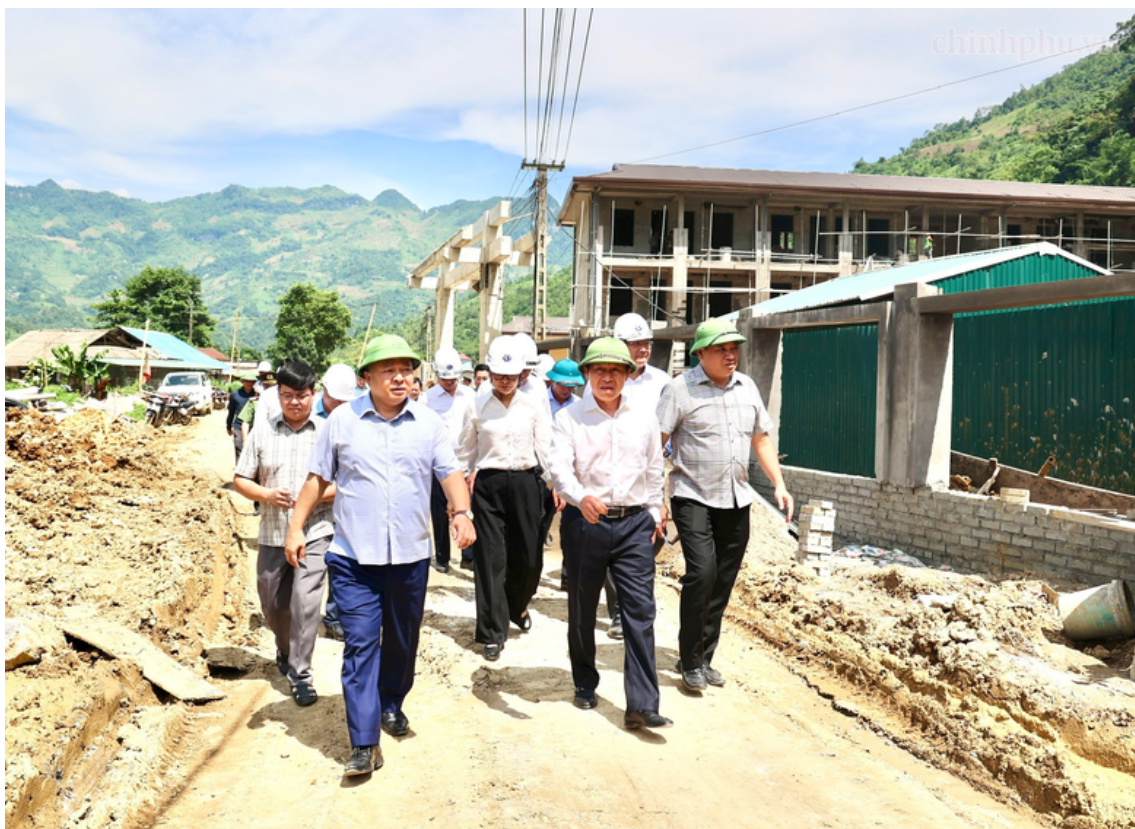
Phó Thủ tướng Lê Tiến Châu kiểm tra thực địa tiến độ xây dựng Trường phổ thông nội trú liên cấp tiểu học và trung học cơ sở Minh Tân - Ảnh: VGP/Thu Sa
