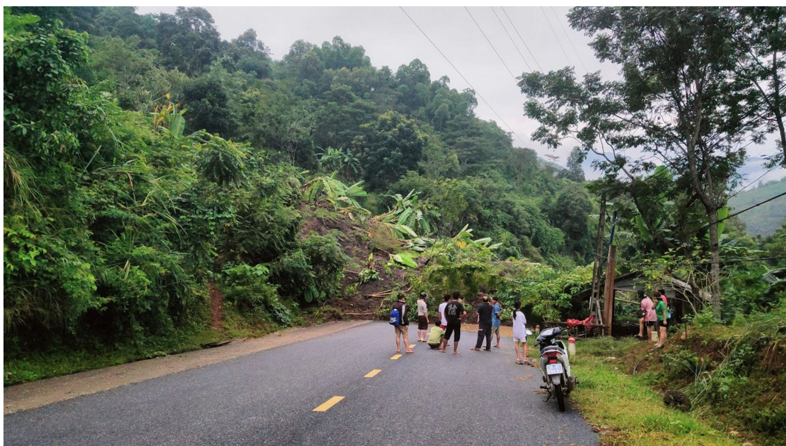
Điểm sạt lở trên tuyến QL15C gần cổng Trường PTDT BẮN TRÚ THCS Pù Nhi, huyện Mường Lát, tỉnh Thanh Hóa
