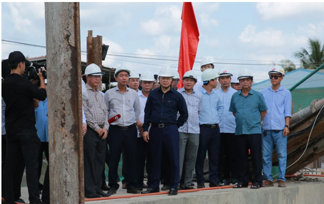
Phó Thủ tướng Trần Hồng Hà kiểm tra và nghe báo cáo tiến độ công trình cống âu Nguyễn Tấn Thành. Ảnh VGP/Minh Khôi.
