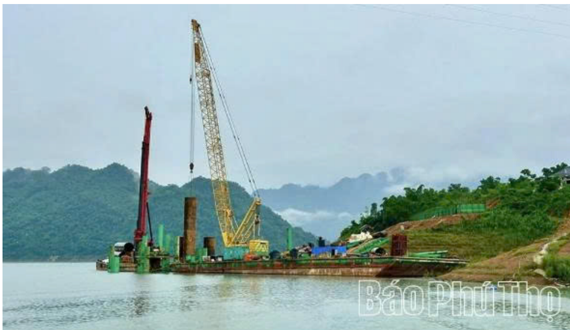
Đẩy nhanh tiến độ thi công dự án cầu Hòa Sơn, thuộc dự án cao tốc Hòa Bình - Mộc Châu (Ảnh: Báo Phú Thọ)
