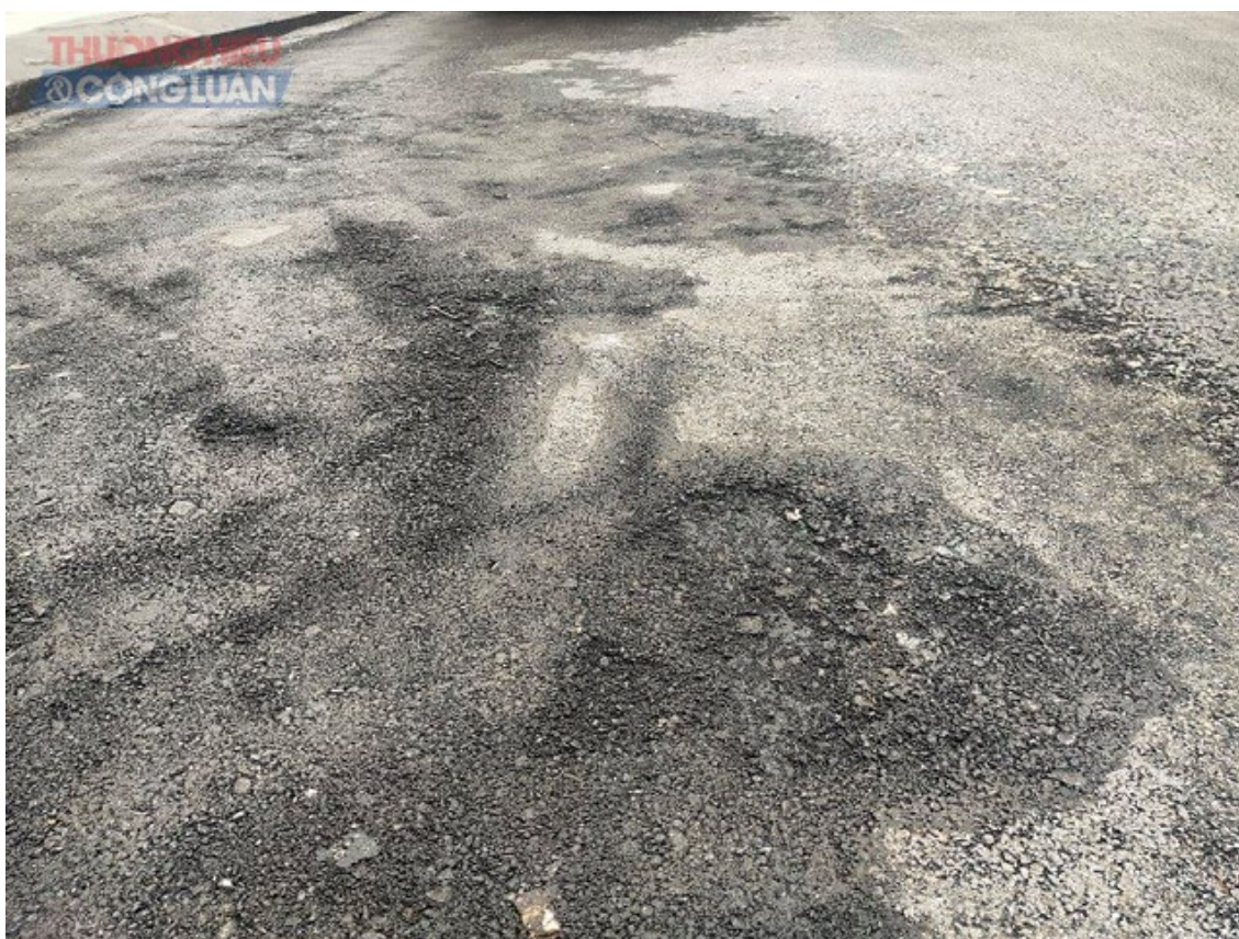
Để khắc phục mặt đường bê tông nhựa vừa mới làm xong đã bị bong chóc, lồi lõm.
