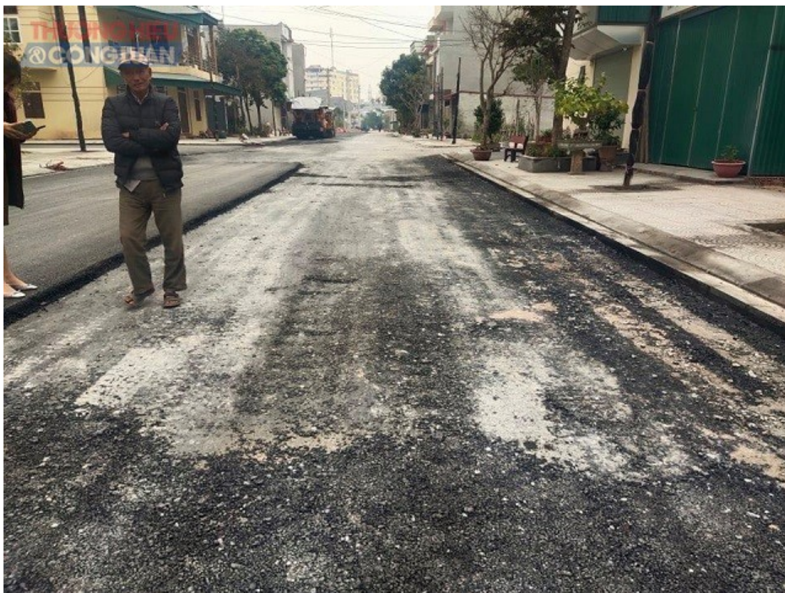
Hiện công trình tạm dừng thi công mặt đường trải thảm bê tông nhựa mới
