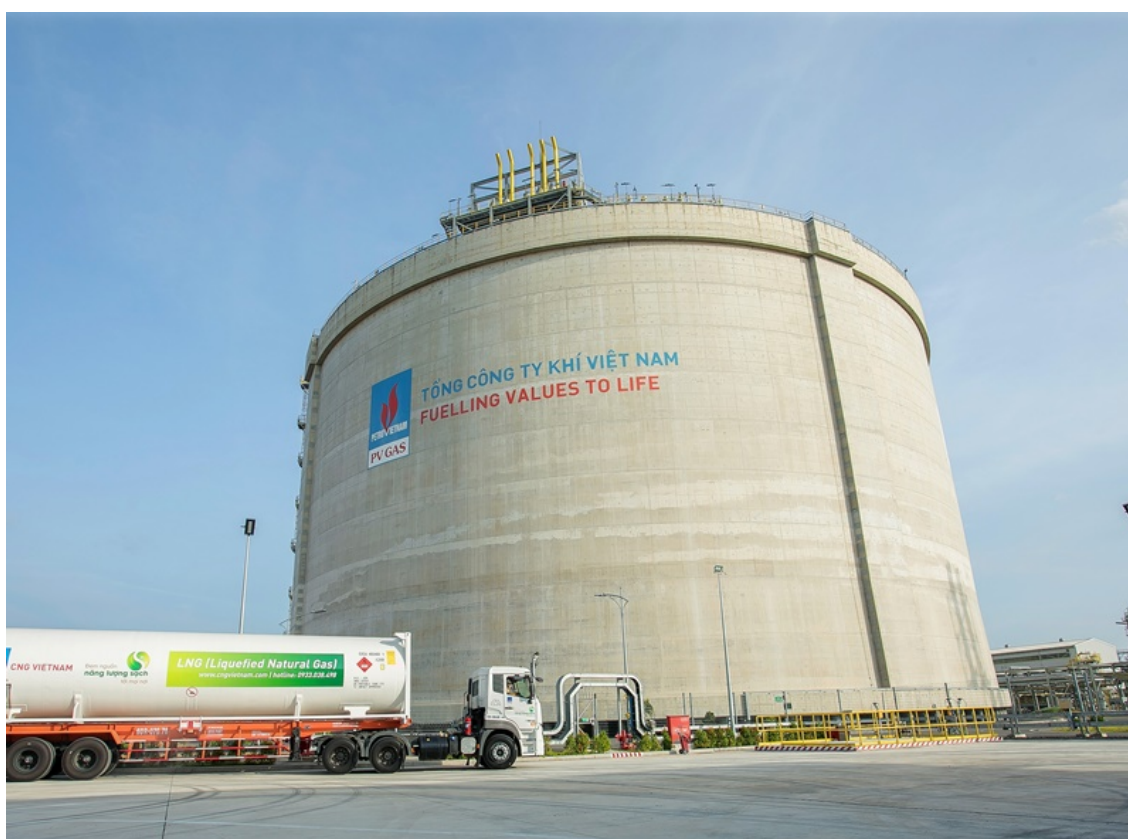
PV GAS quản lý và vận hành kho LNG 1 MMTPA Thị Vải - kho LNG đầu tiên tại Việt Nam
