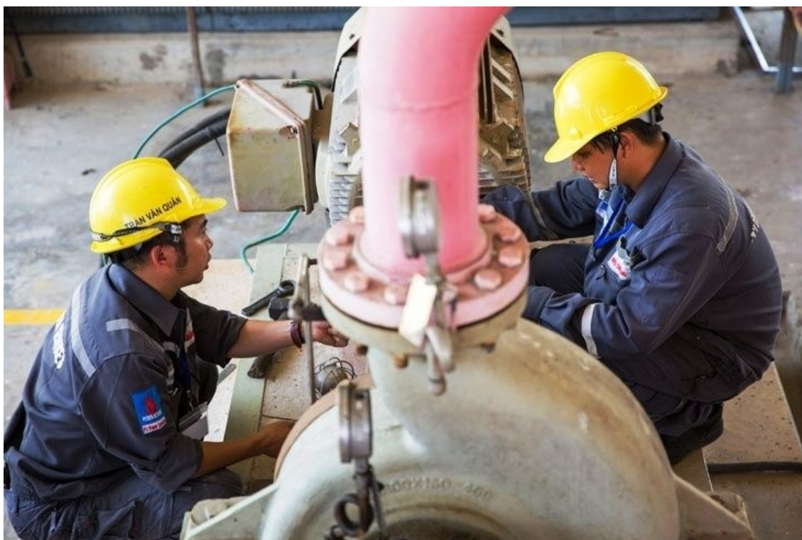
Người lao động PV Power Services đang làm nhiệm vụ bảo trì, bảo dưỡng và sửa chữa các nhà máy điện
