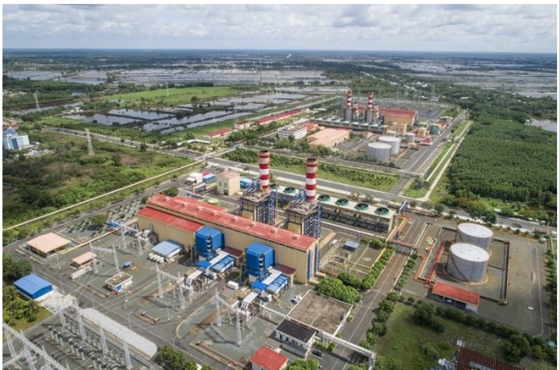
Nhà máy điện của PV Power. Ảnh PV Power
