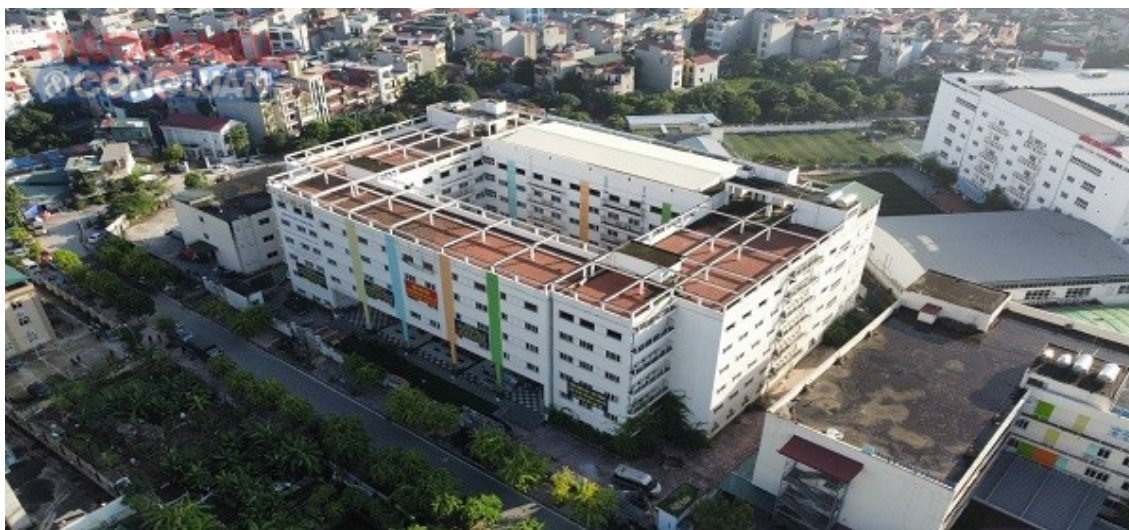
Tòa nhà TH1, Khu đô thị mới Cổ Nhuế, phường Cổ Nhuế 1, quận Bắc Từ Liêm nơi tổ chức cưỡng chế trả lại trường học cho Trường Newton
