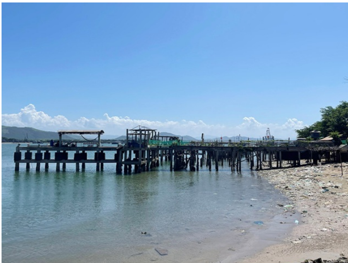
Một công trình vi phạm hành lang bảo vệ đê điều tại Quảng Bình chưa được xử lý dứt điểm.
