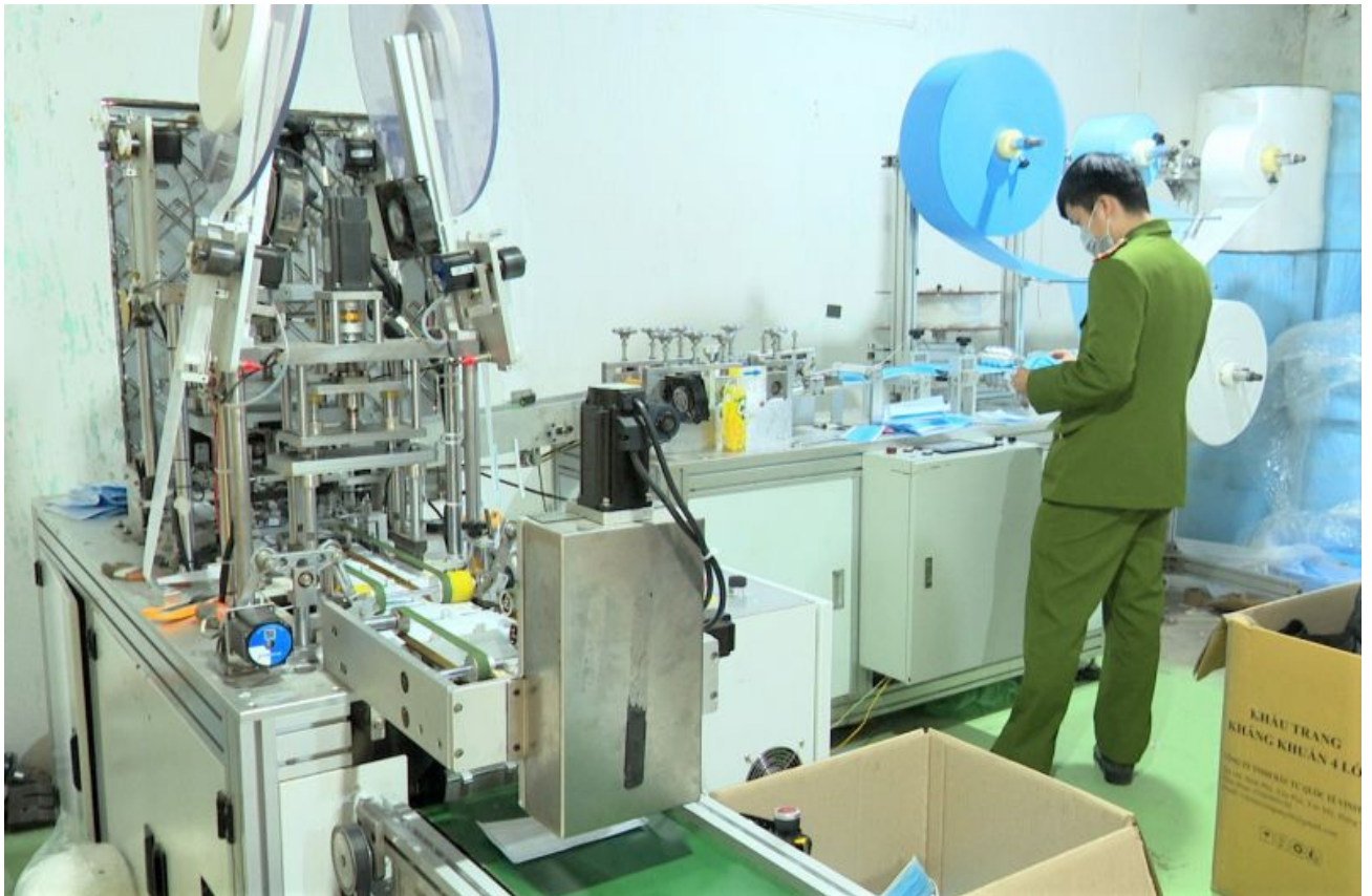
Hệ thống máy móc dùng sản xuất khẩu trang tại cơ sở không phép, nguồn ảnh Thanh Niên.
