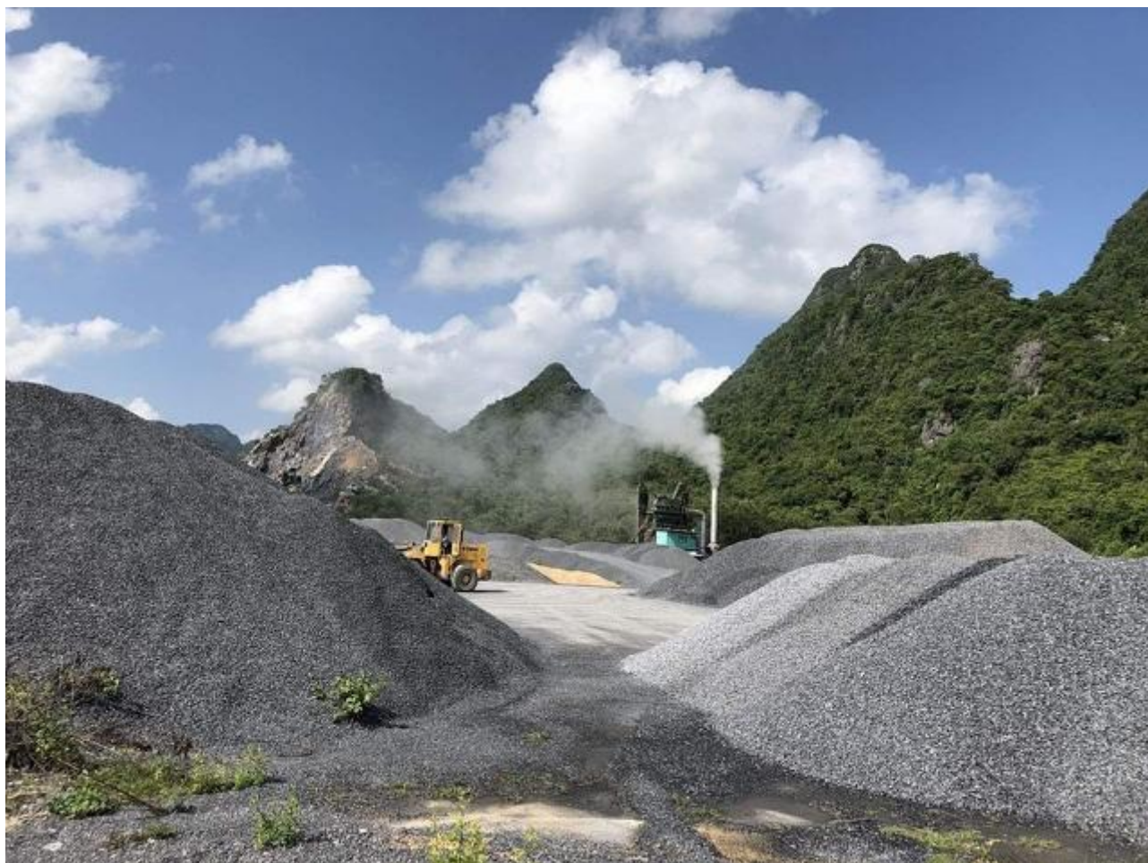
Trạm trộn bê tông không phép của Công ty TNHH Thực Linh bị đình chỉ hoạt động
