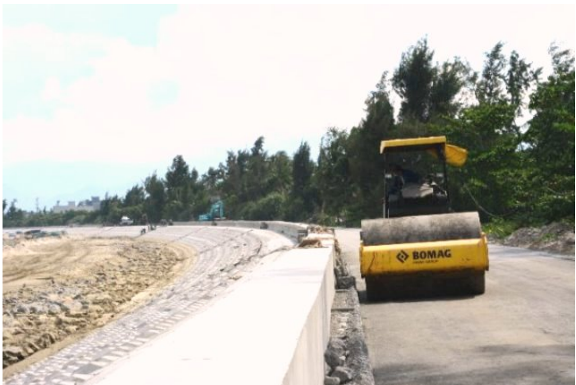
Đoạn đầu công trình kè.
