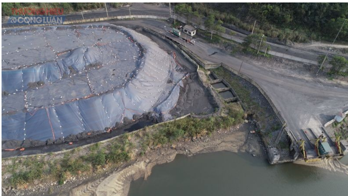
Hệ thống thu gom nước thải qua bể lắng rồi xả thẳng ra sông Diễn Vọng.
