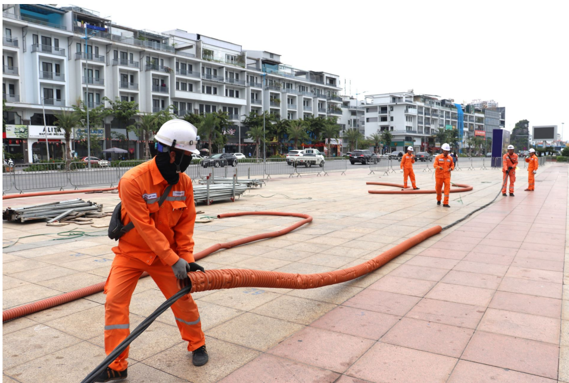
Công nhân ngành Điện lắp đặt đường điện phục vụ chương trình.
