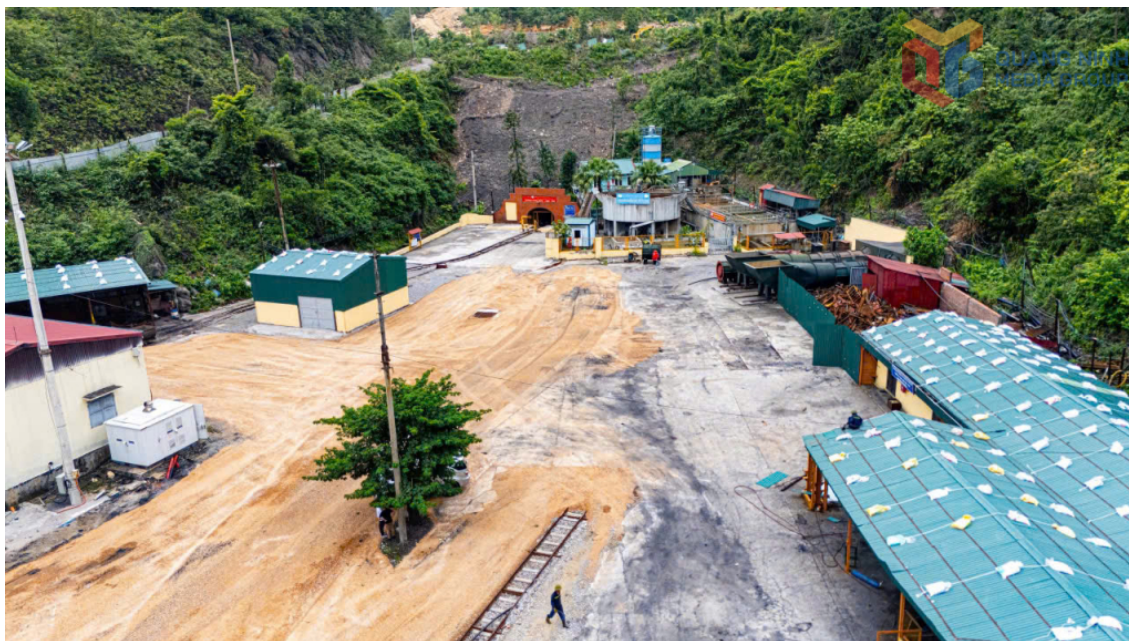
Ngày 19/8, Dự án khai thác hầm lò phần mở rộng mỏ Hà Ráng (Công ty Than Hòn Gai) chính thức khởi công. (Ảnh: QMG)
