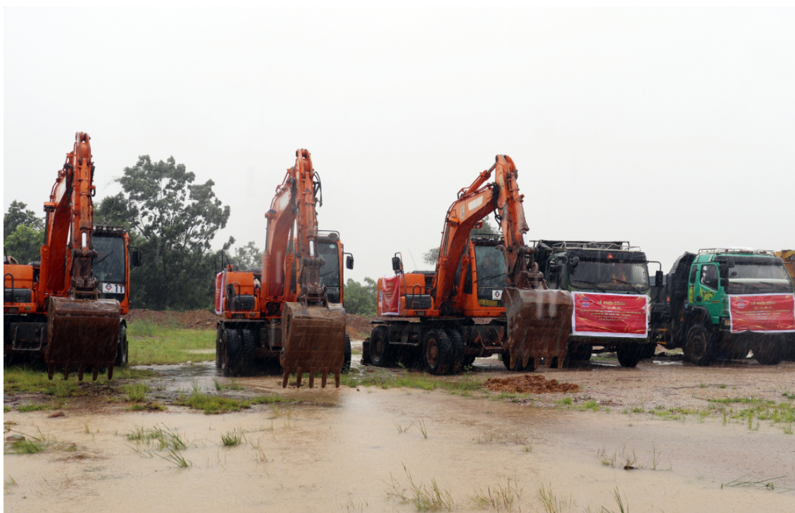
Các phương tiện, máy móc tiến hành khởi công dự án.
