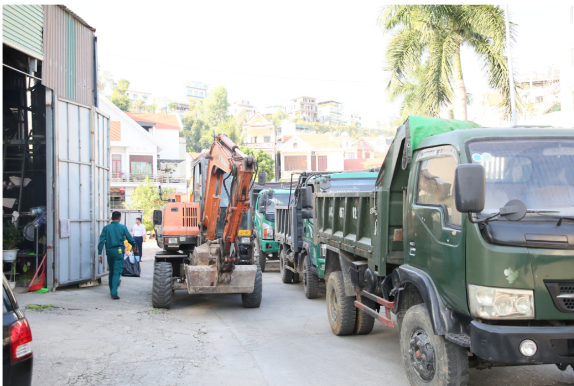
Máy móc, phương tiện được tập kết để triển khai thi công dự án. (Ảnh: QMG)
