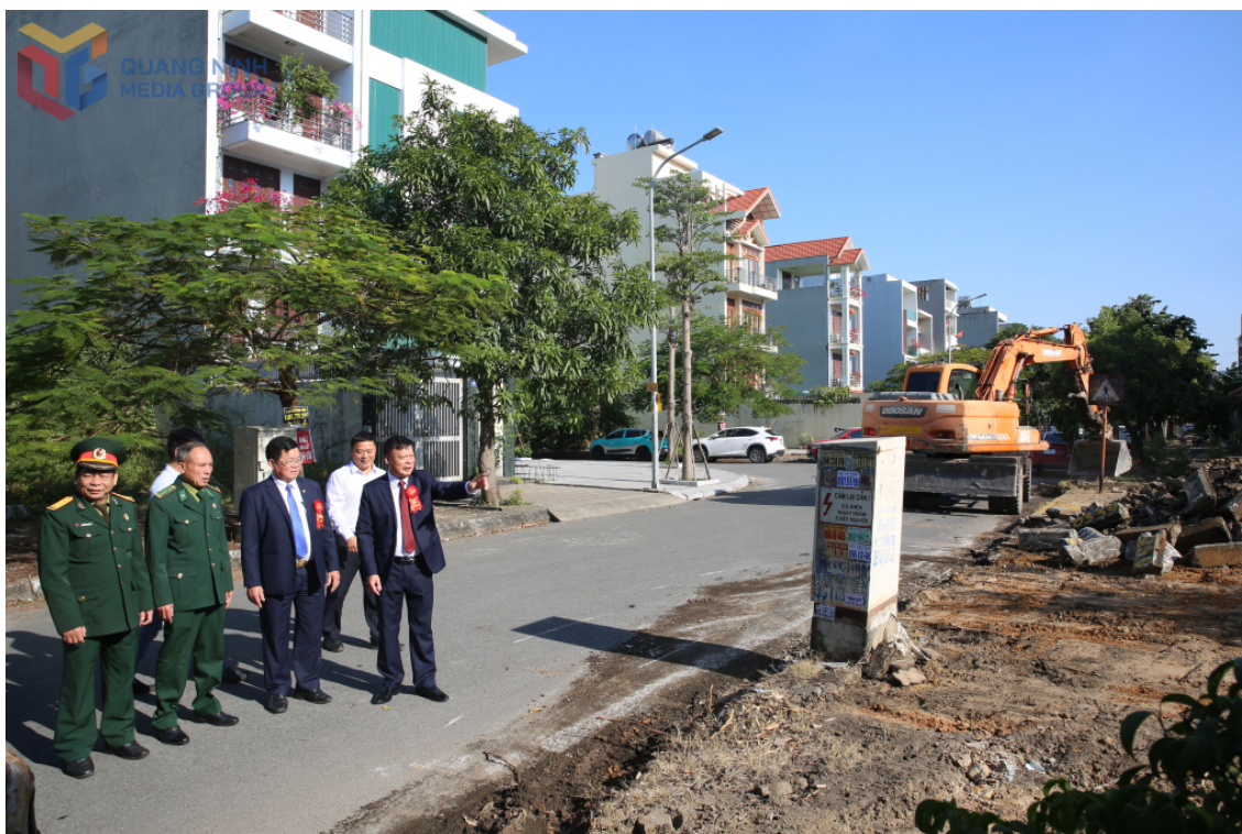
Đại biểu và người dân tham gia khởi công tại khu vực dự án Licogi mở rộng Cột 8, khu 6, phường Hạ Long. (Ảnh: QMG)
