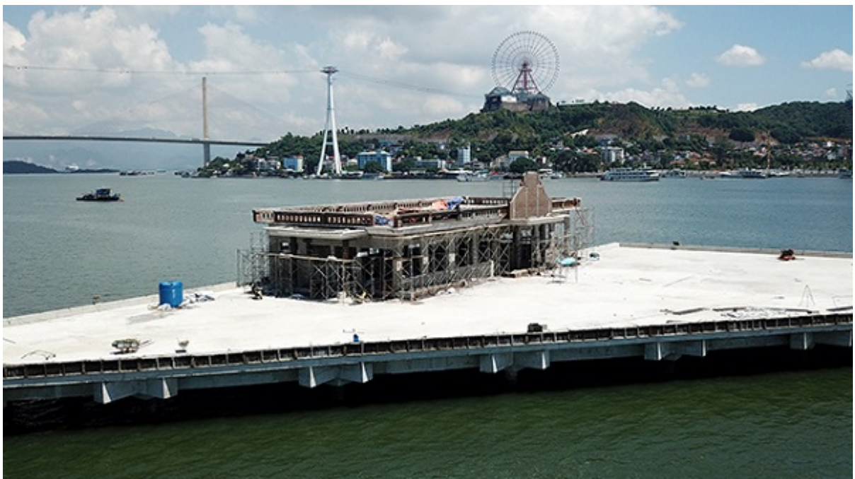
Vùng quay đầu xe và nhà công vụ đang hoàn thiện
