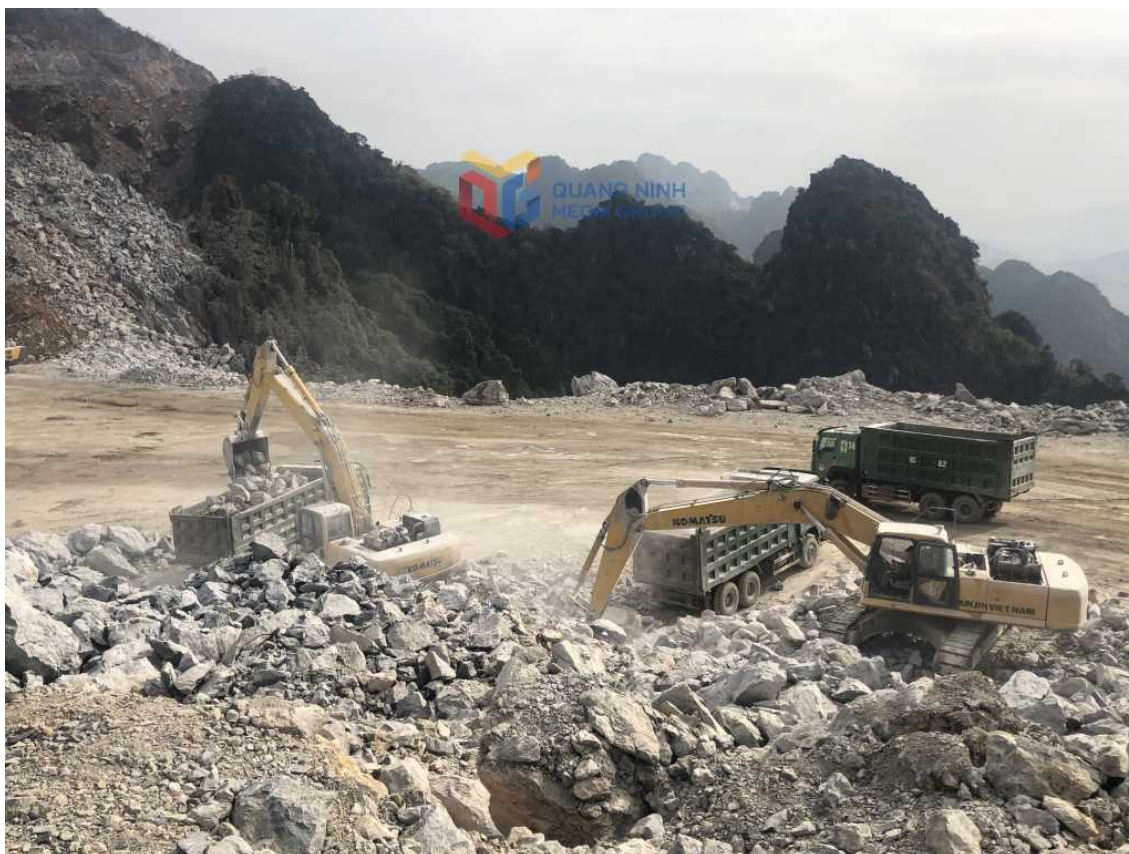
Khai thác đá phục vụ sản xuất của Nhà máy xi măng Hạ Long (Ảnh: QMG)
