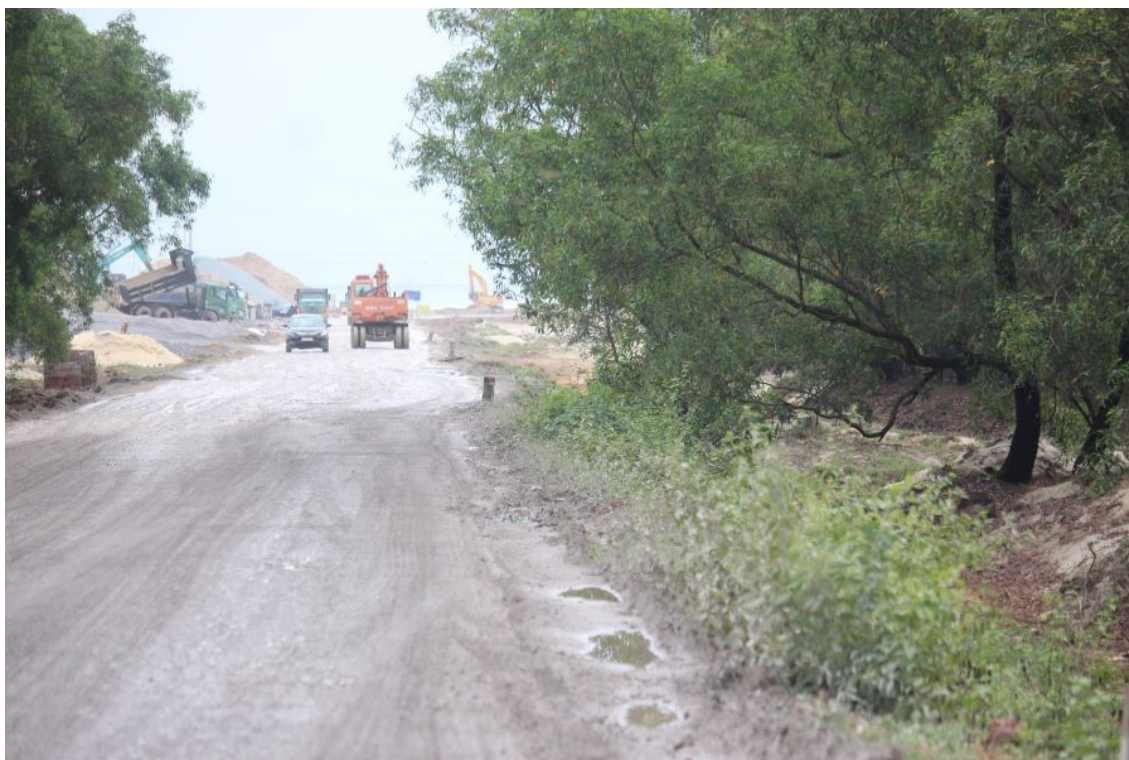
UBND tỉnh Quảng Trị yêu cầu các địa phương bàn giao toàn bộ mặt bằng thi công dự án QL15D trước ngày 30/4 (Ảnh: DL)
