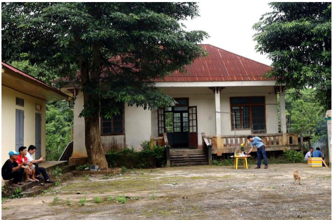
Vị trí khởi công sửa chữa làm nhà sinh hoạt cộng đồng bản Chăm Pu.
