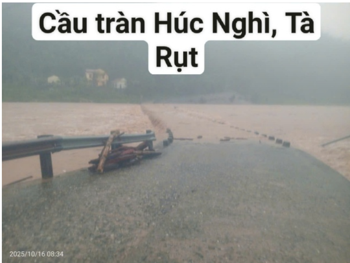
Cầu tràn Húc Nghi, Tà Rụt bị nước lũ chia cắt. (Ảnh: Ban Chỉ huy PCTT)
