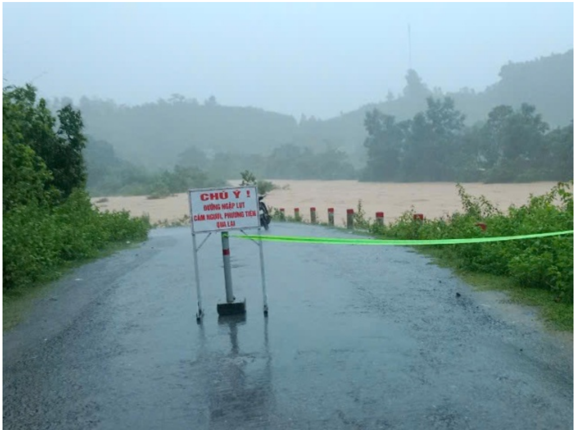
Cầu Trần Ly Tôn (km28), thôn Ly Tôn xã Đakrông bị nước lũ dâng cao, lực lượng chức năng đã cắm biển cảnh báo, cấm người qua lại.
