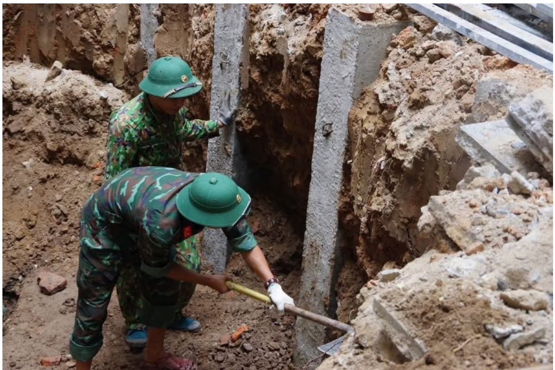
Đội Quy tập hài cốt liệt sĩ 584 tìm kiếm và quy tập được 4 hài cốt liệt sĩ tại khu vực công trường thi công Bệnh viện đa khoa khu vực Thạch Hãn
