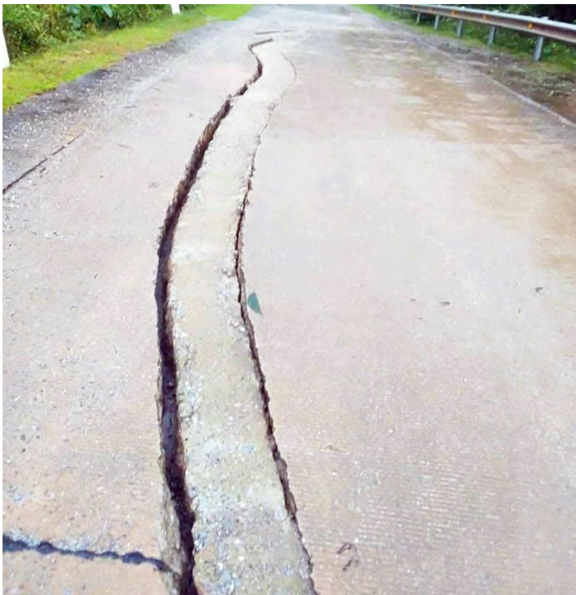
Vết nứt có chiều dài khoảng 40m, độ sâu 22cm trên đường Hồ Chí Minh nhánh Tây đoạn qua xã Trường Sơn.
