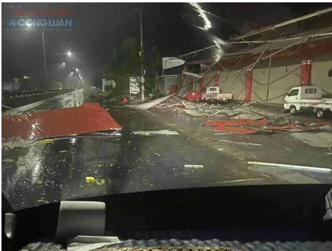
Tại Quảng Trị, mưa lớn kèm gió giật đã cuốn bay nhiều mái tôn, làm hư hỏng đồ đạc bên trong nhà dân. Một số hộ phải sơ tán khẩn cấp đến nơi trú ẩn an toàn.
