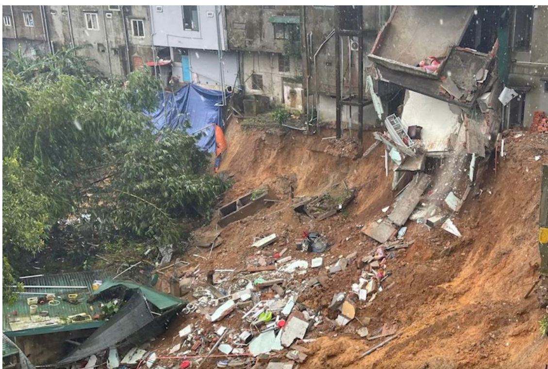
Sạt lở khiến 1 ngôi nhà 2 tầng bị sụp đổ và nhiều ngôi nhà đang trong nguy cơ mất an toàn
