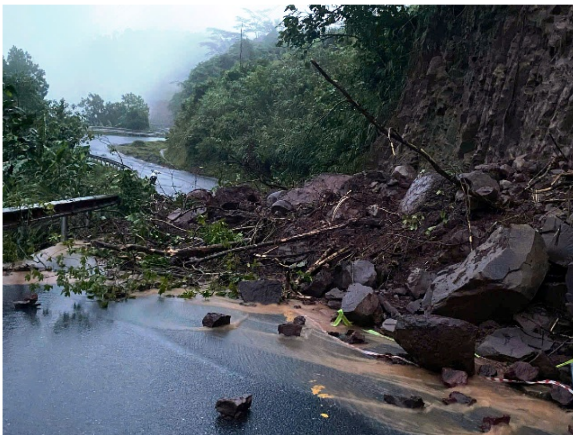
Nhiều tuyến đường bị sạt lở, chia cắt tạm thời.
