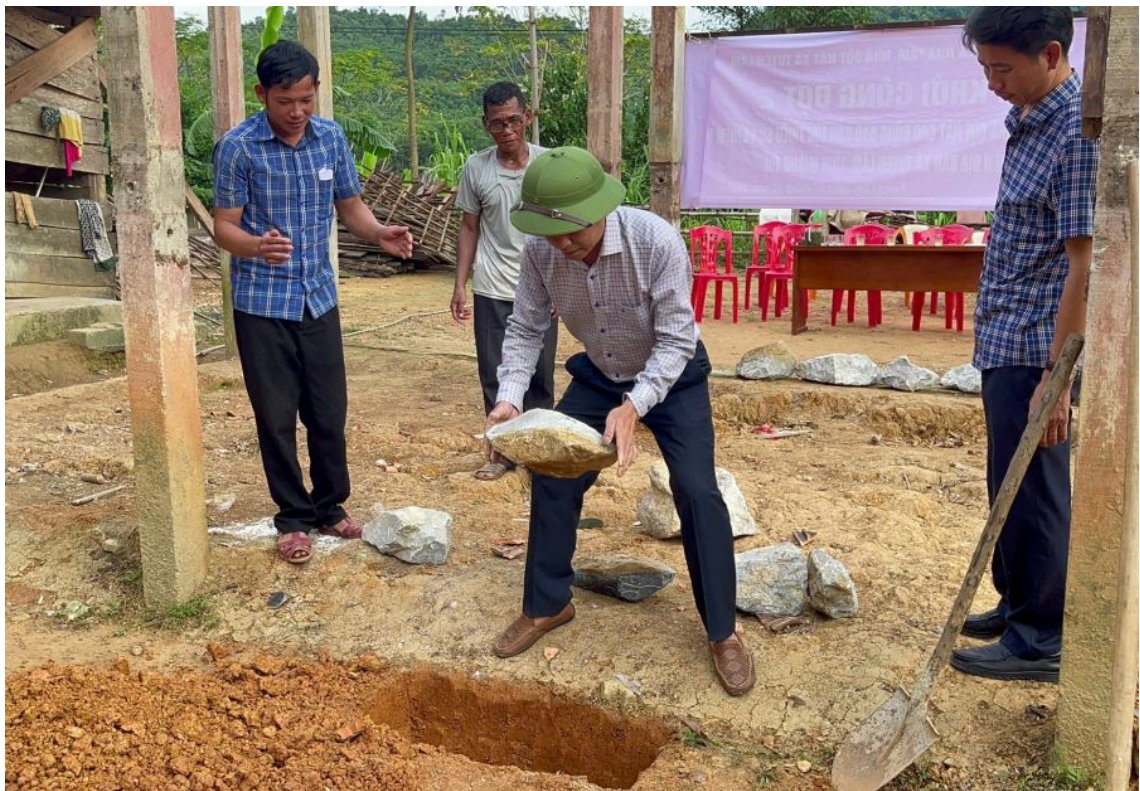
Lãnh đạo xã Tuyên Lâm tham gia khởi công xây dựng nhà cho người dân. (Ảnh: XV)
