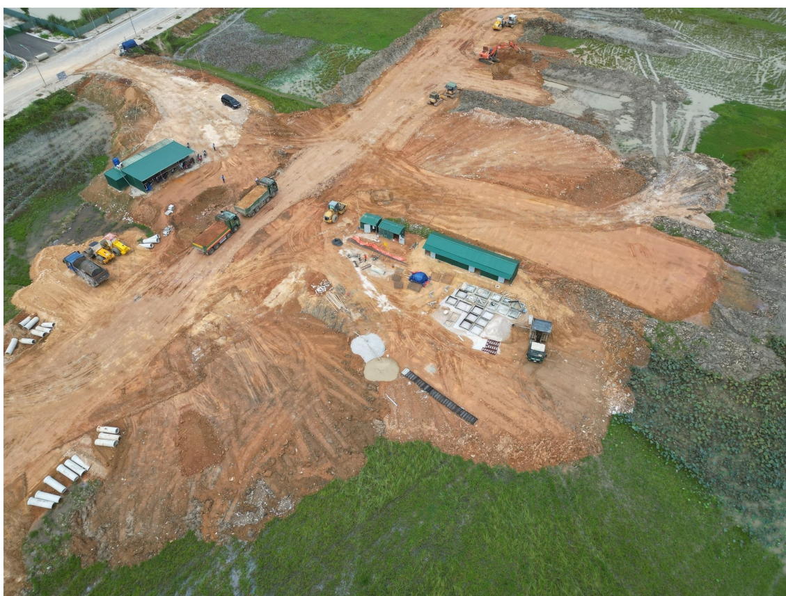
Hình ảnh một dự án khu dân cư tại TP. Thanh Hóa đang triển khai công tác san lấp mặt bằng. (Ảnh: minh họa)
