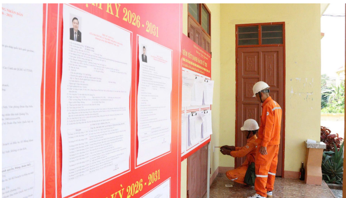
Nhân viên Điện lực kiểm tra điện tại 1 điểm bầu cử ở tỉnh Quảng Trị. Nguồn ảnh: ĐVCC
