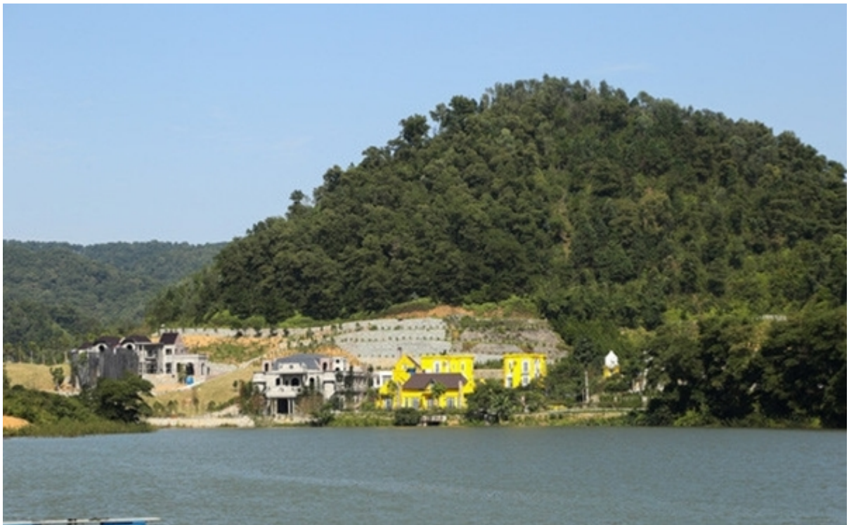
Hàng loạt công trình, biệt thự mọc trên đất rừng Sóc Sơn
