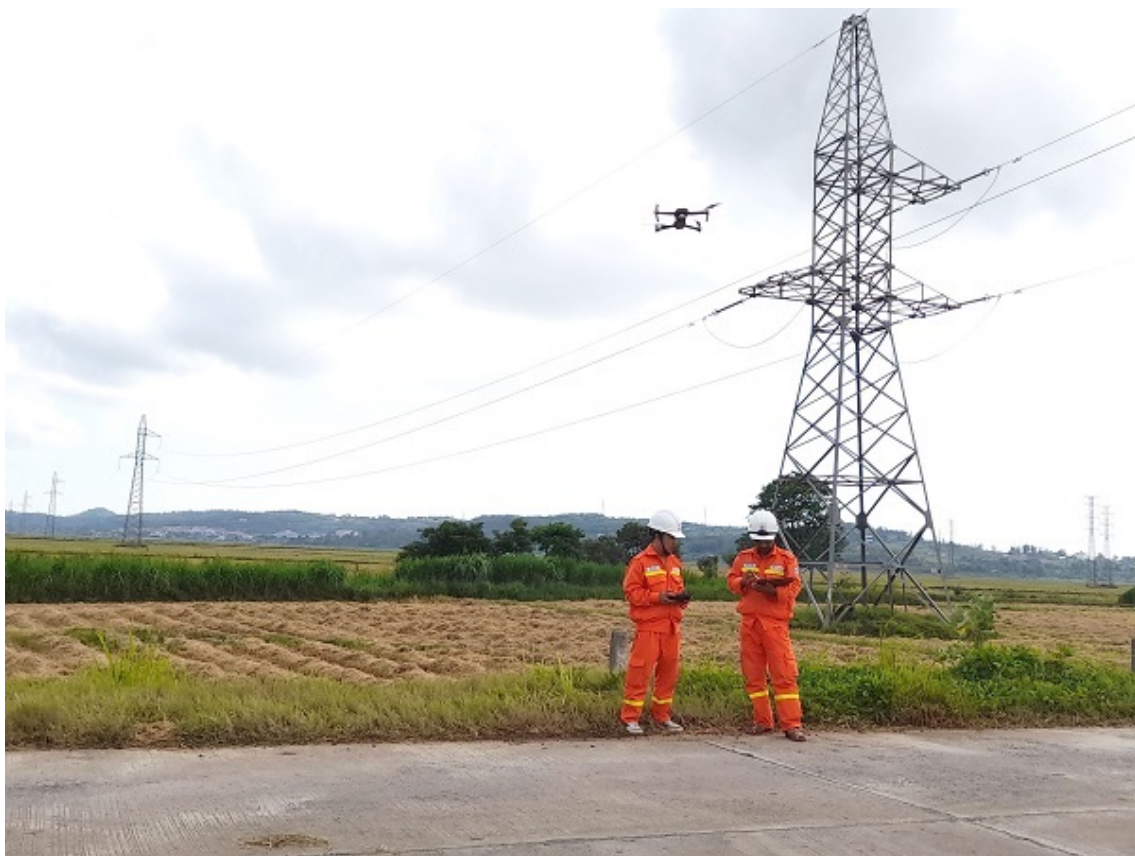
Truyền tải điện Phú Yên đang sử dụng UAV kiểm tra tuyến đường dây 220kV Tuy Hòa - Quy Nhơn
