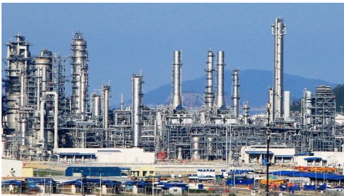
Nhà máy lọc hóa dầu Nghi Sơn
