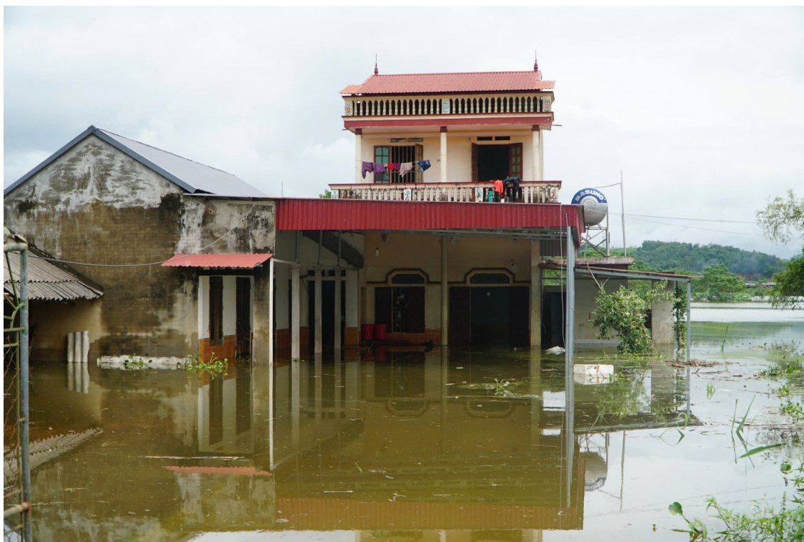
Nhiều đoạn đường bị ngập sâu đến 1,7m.
