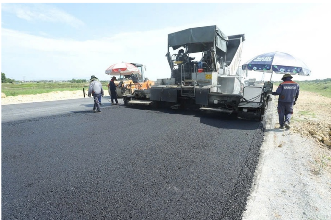
Siết chặt quản lý chất lượng, an toàn trong thi công xây dựng kết cấu hạ tầng giao thông. Ảnh VGP.
