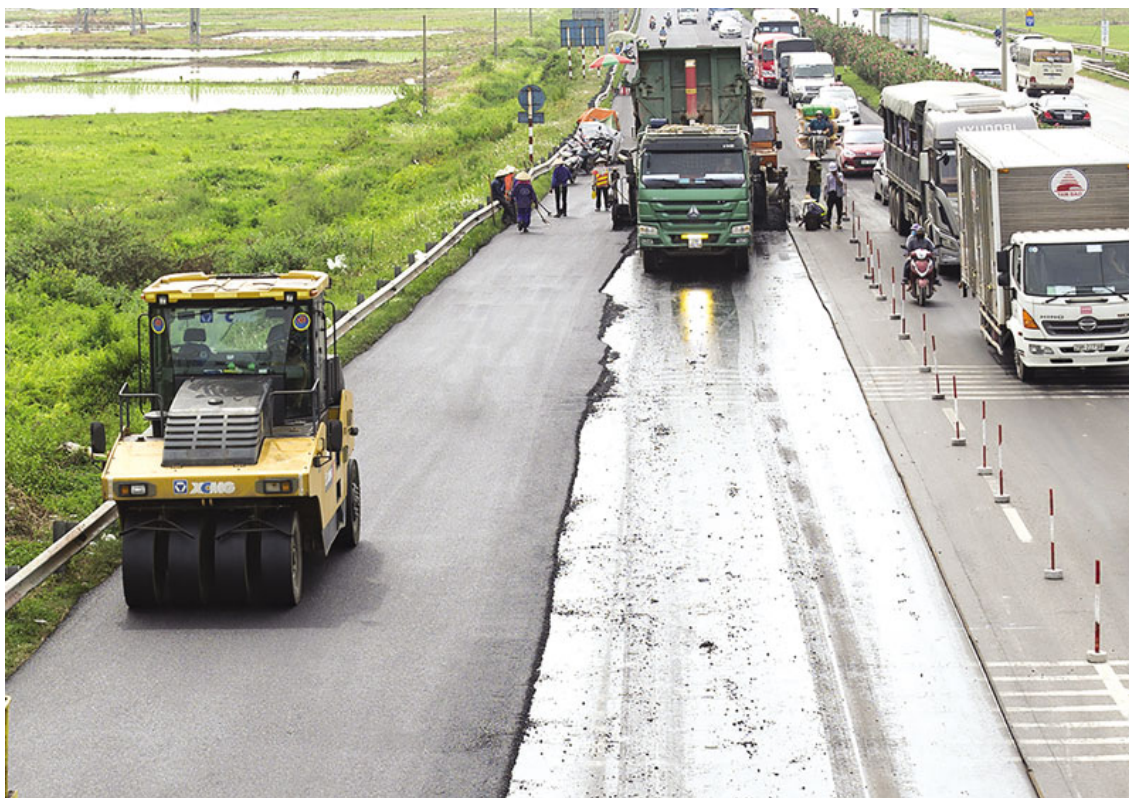
Siết chặt quản lý chất lượng, an toàn trong thi công xây dựng kết cấu hạ tầng giao thông. Ảnh chỉ có tính minh họa, nguồn internet.
