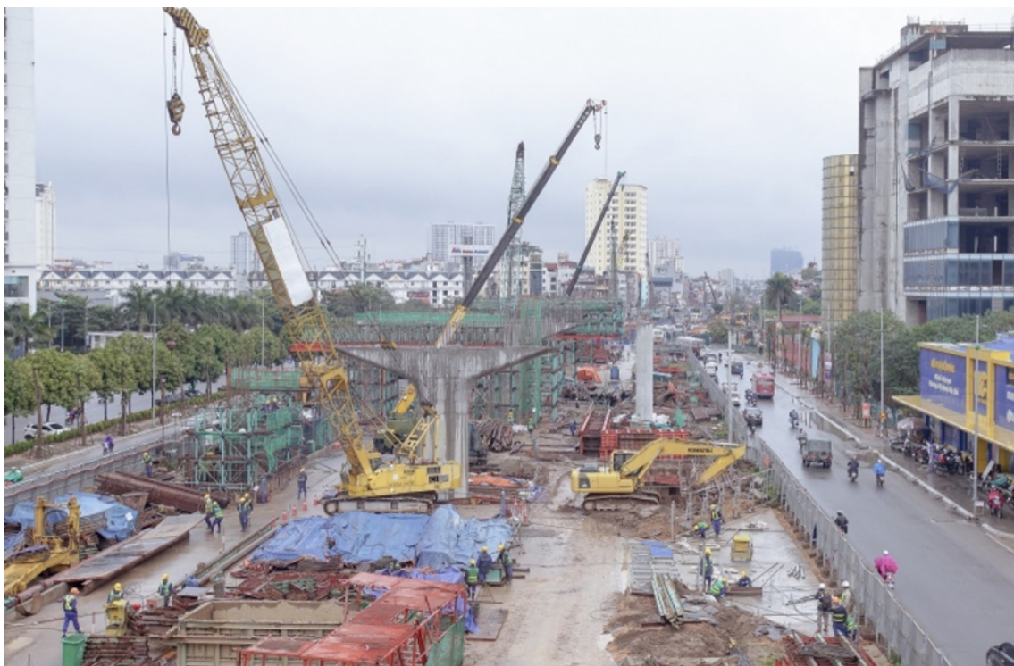
Siết chặt quản lý chất lượng, an toàn trong thi công xây dựng kết cấu hạ tầng giao thông. Ảnh chỉ có tính minh họa, nguồn internet.
