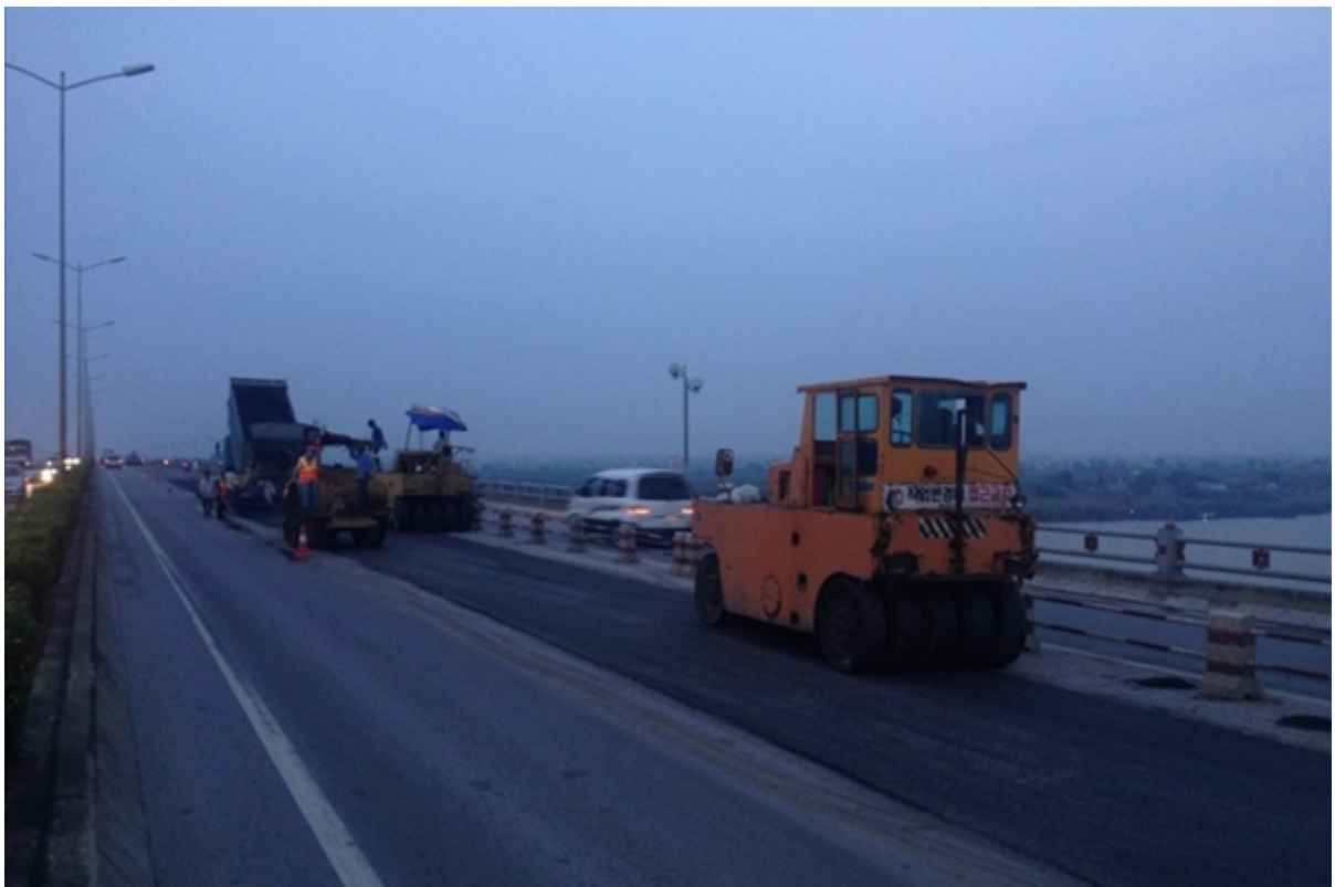
Thi công sửa chữa vết hằn lún trên mặt cầu Thanh Trì
