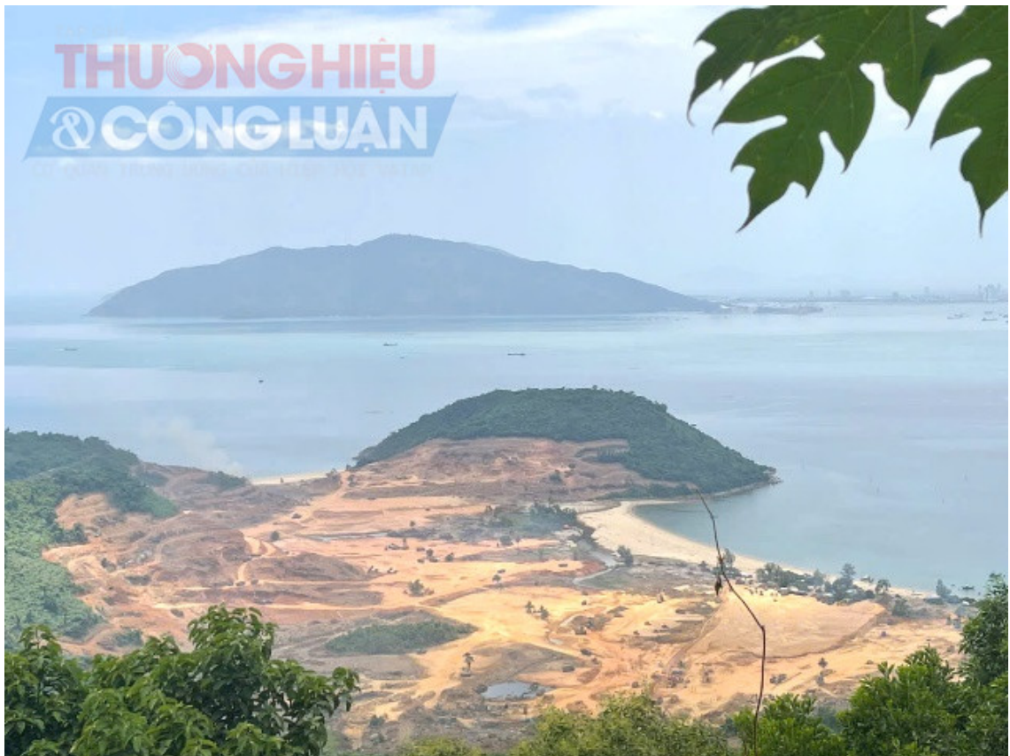
Sôi động trên đại công trình siêu dự án Làng Vân Đà Nẵng . Ảnh: Lê Dũng
